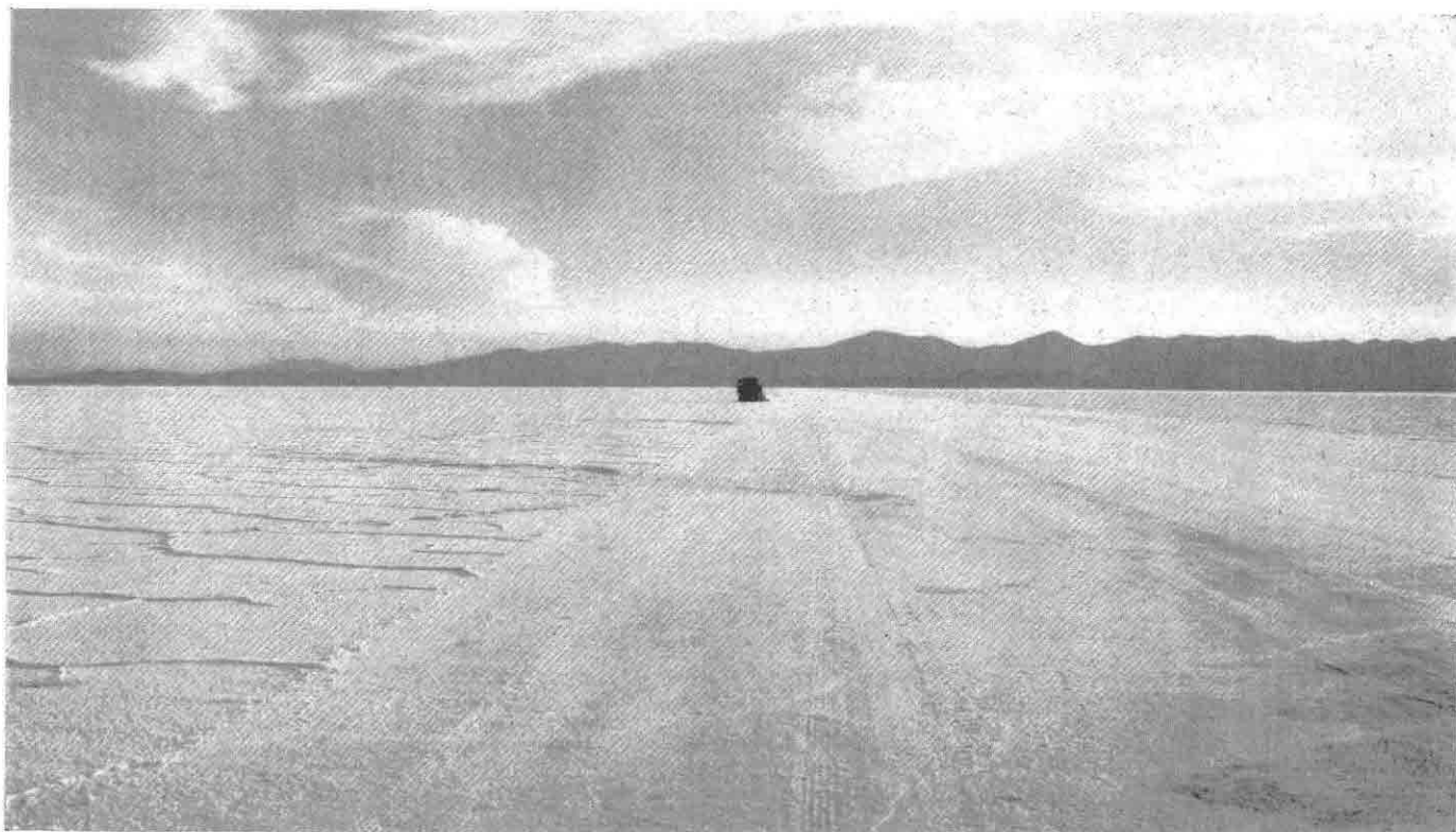
La préparation de la piste utilisée par Sir Molcolm CAMPBELL. Un tracteur, remorquant une sorte de herse composée de barres de fer, parcourt à plusieurs reprises les 21 kilomètres de la piste pour niveler la surface et supprimer les monticules de sel.
