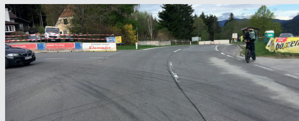
Échappatoire adaptée, à 90° par rapport au virage à gauche, et barrières de sécurité adaptées
