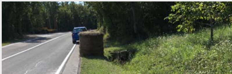
Système d'évacuation en béton non protégé
