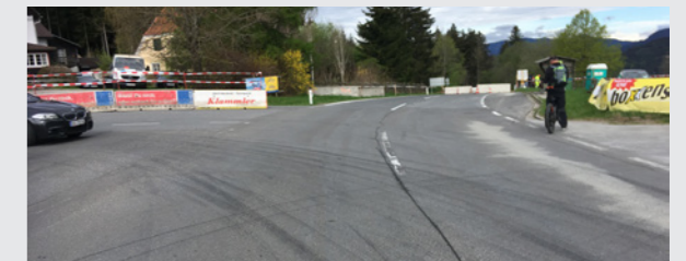
Échappatoire adaptée, à 90° par rapport au virage à gauche, et barrières de sécurité adaptées
