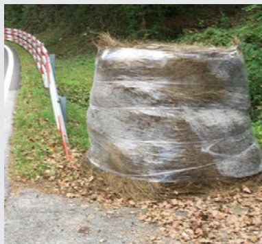
Extrémité de la glissière non protégée
